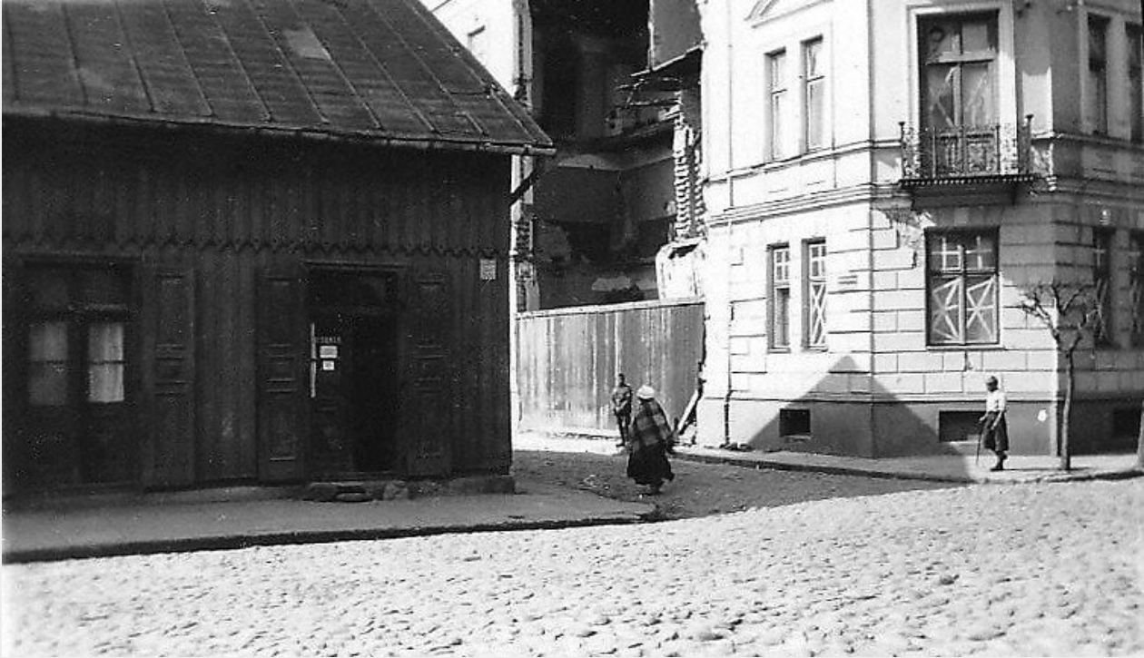
Kamienica przy ul. Jagiellońskiej 27. Podczas odbudowy i remontu usunięto wszystkie elementy architektoniczne z elewacji.
