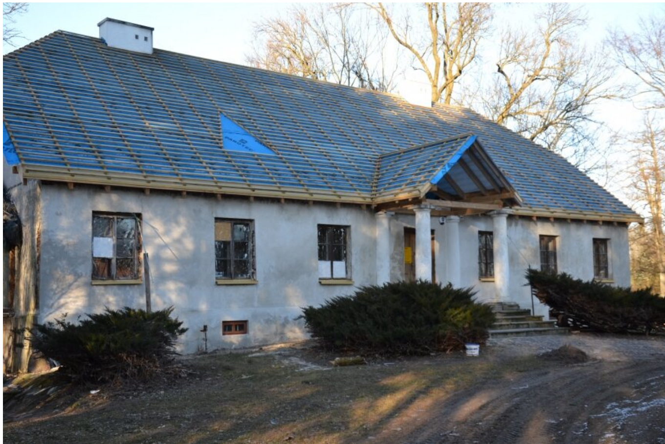
Dwór w Pertykozach przechodzi remont. (Justyna Napierała)
