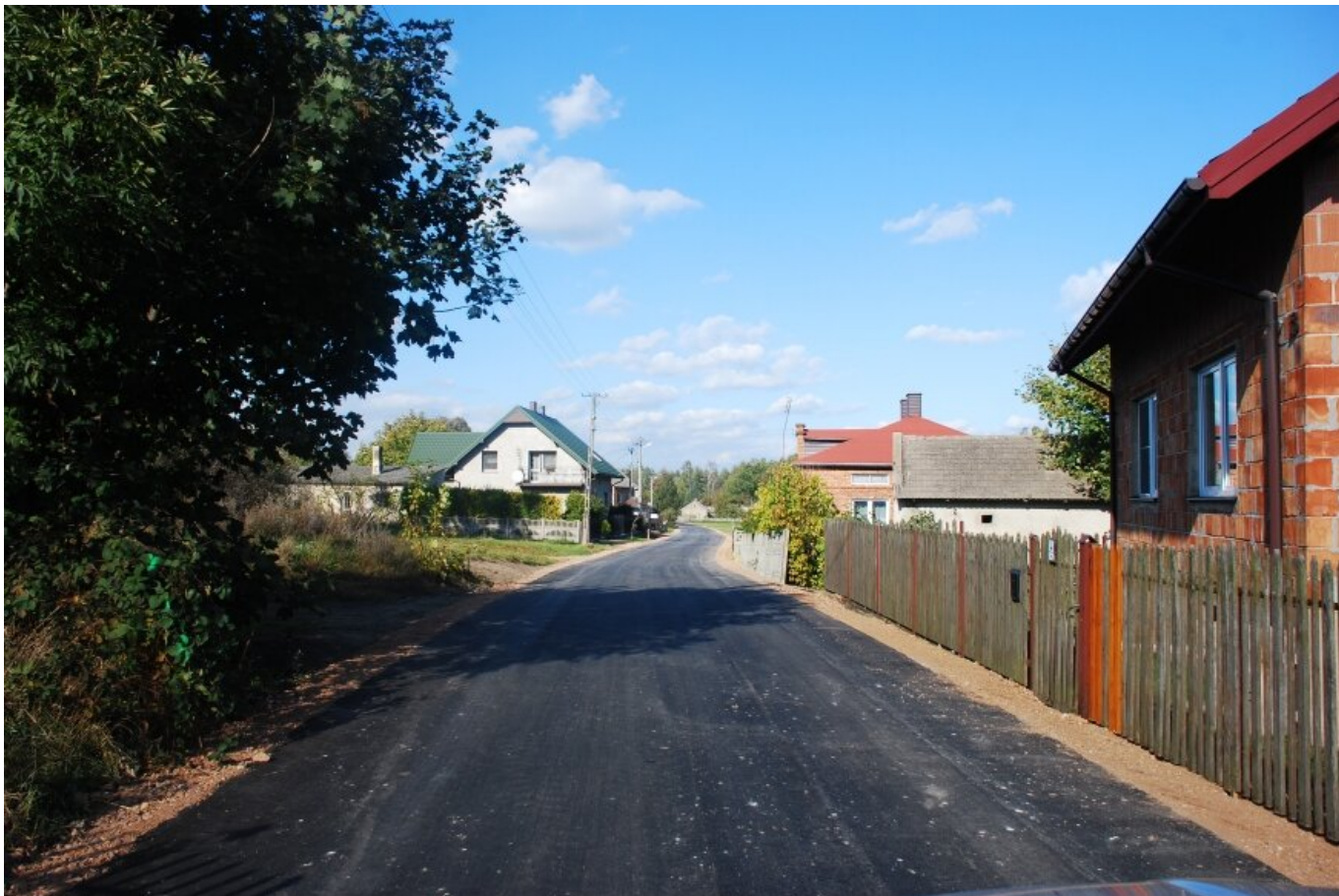
Budowa drogi wreszcie zostanie zakończona. (fot. Beata Pierzchała)
