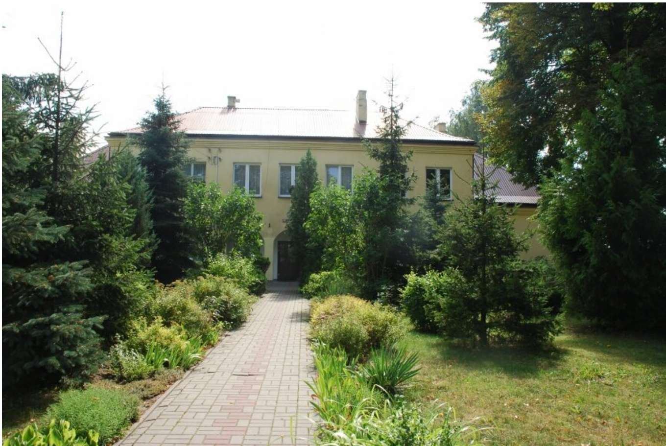
Dach w szkole w Huminie trzeba wyremontować. (fot. Beata Pierzchała)
