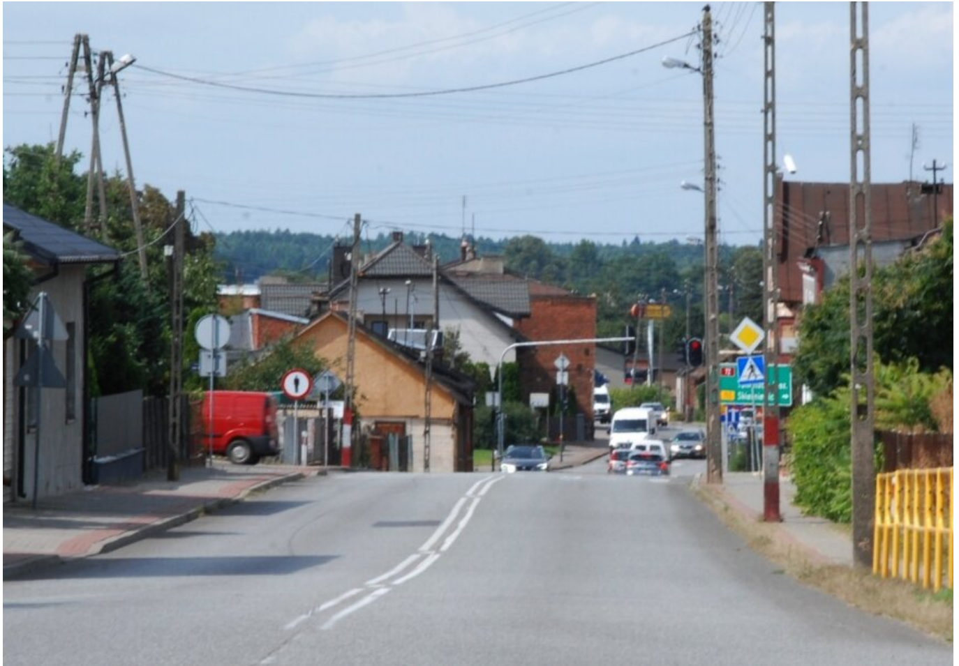
Mieszkańcy głównych ulic w Jeżowie nadal są przyłączeni do wodociągu azbestowymi rurami. (fot. Beata Pierzchała)
