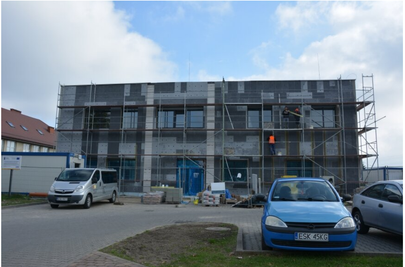
Nowy urząd gminy w Makowie nabiera kształtu. Do finiszu prac już niedaleko. (fot. Beata Pierzchała)
