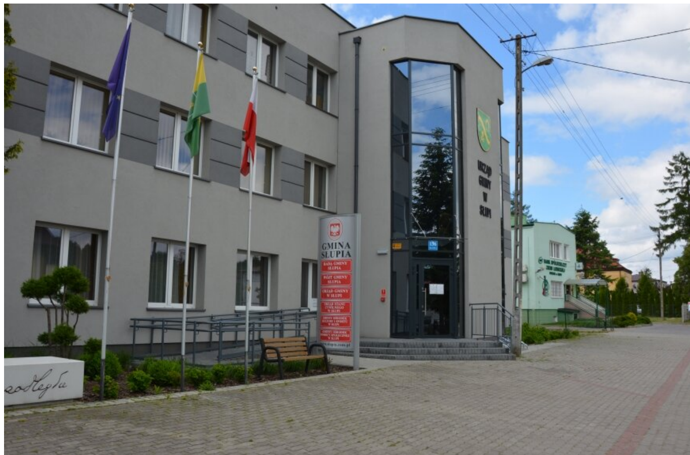
Panele fotowoltaiczne znajdują się między innymi na budynku urzędu gminy. (fot. Beata Pierzchała)
