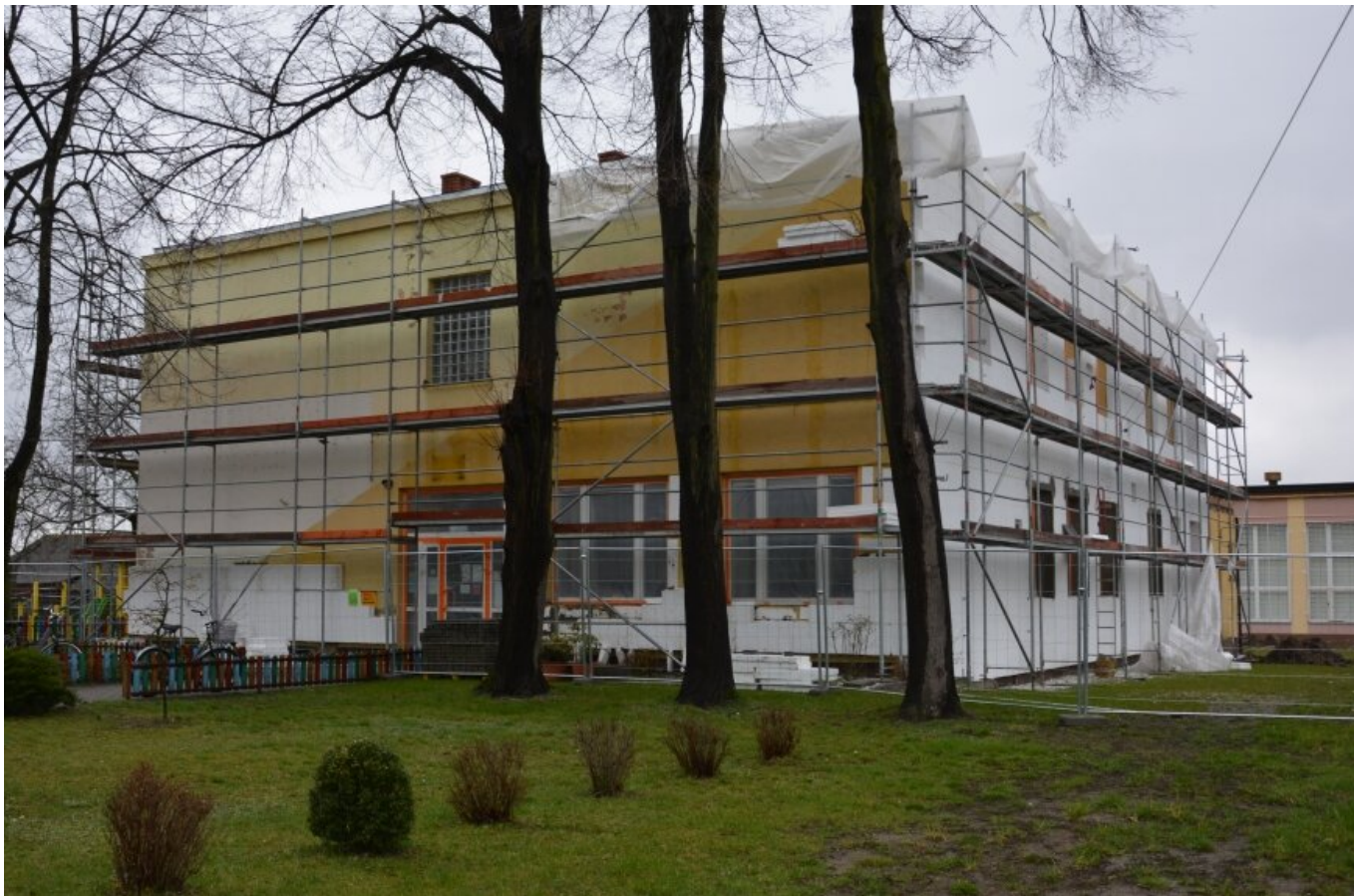
Mała szkoła w Makowie jest jednym z budynków, który będzie poddany termomodernizacji. (fot. Beata Pierzchała)
