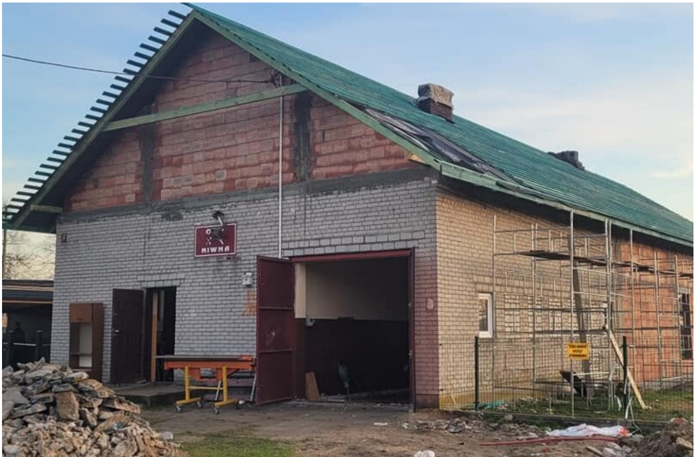
Dawny budynek OSP w Niwnej przechodzi modernizację. (fot. UG Rawa Mazowiecka)
