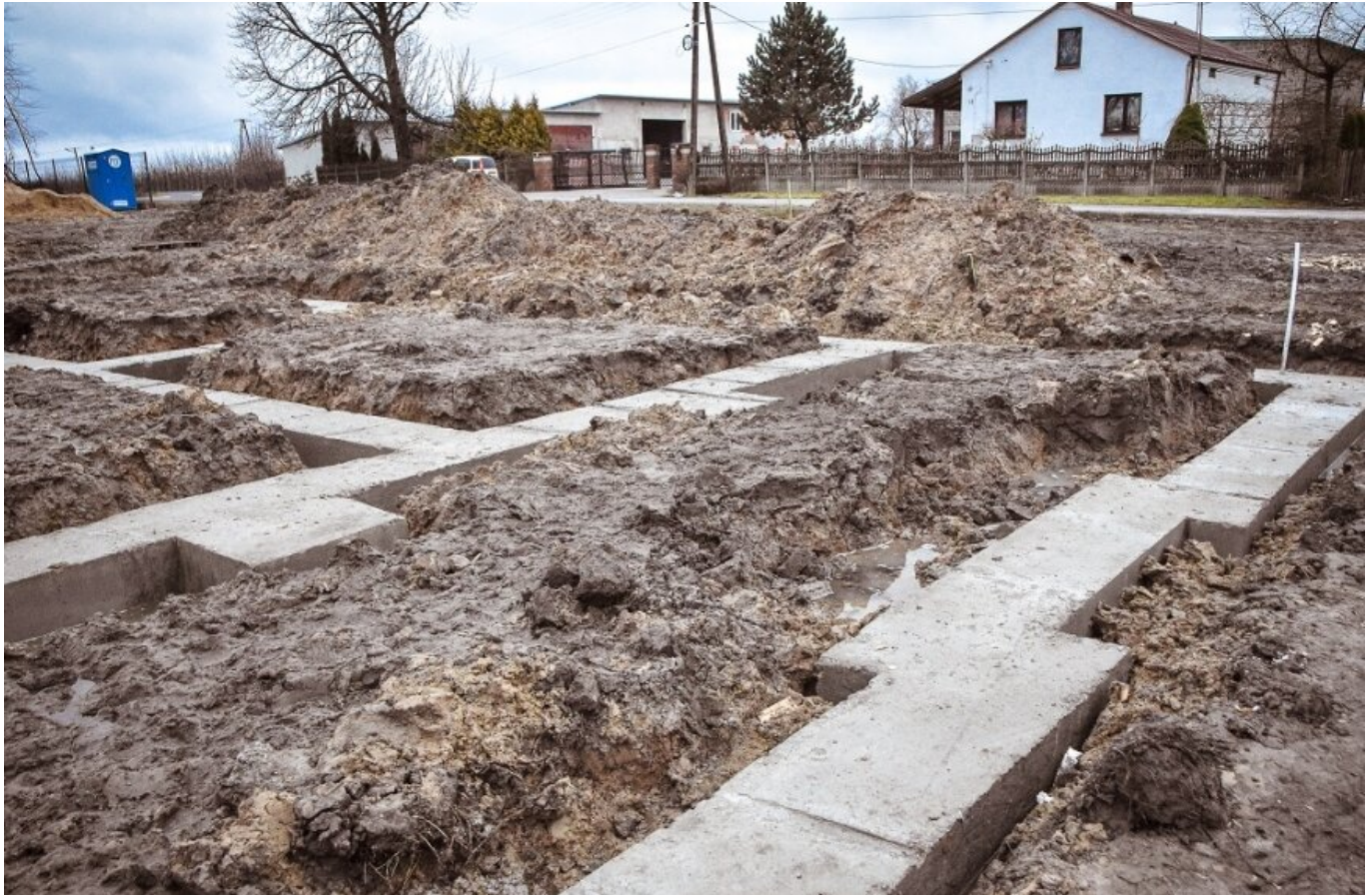
Budynek komunalny z sześcioma mieszkaniami w Błażejewicach powstanie do września przyszłego roku. Fundamenty już są. (Fot. Sławomir Burzyński)
