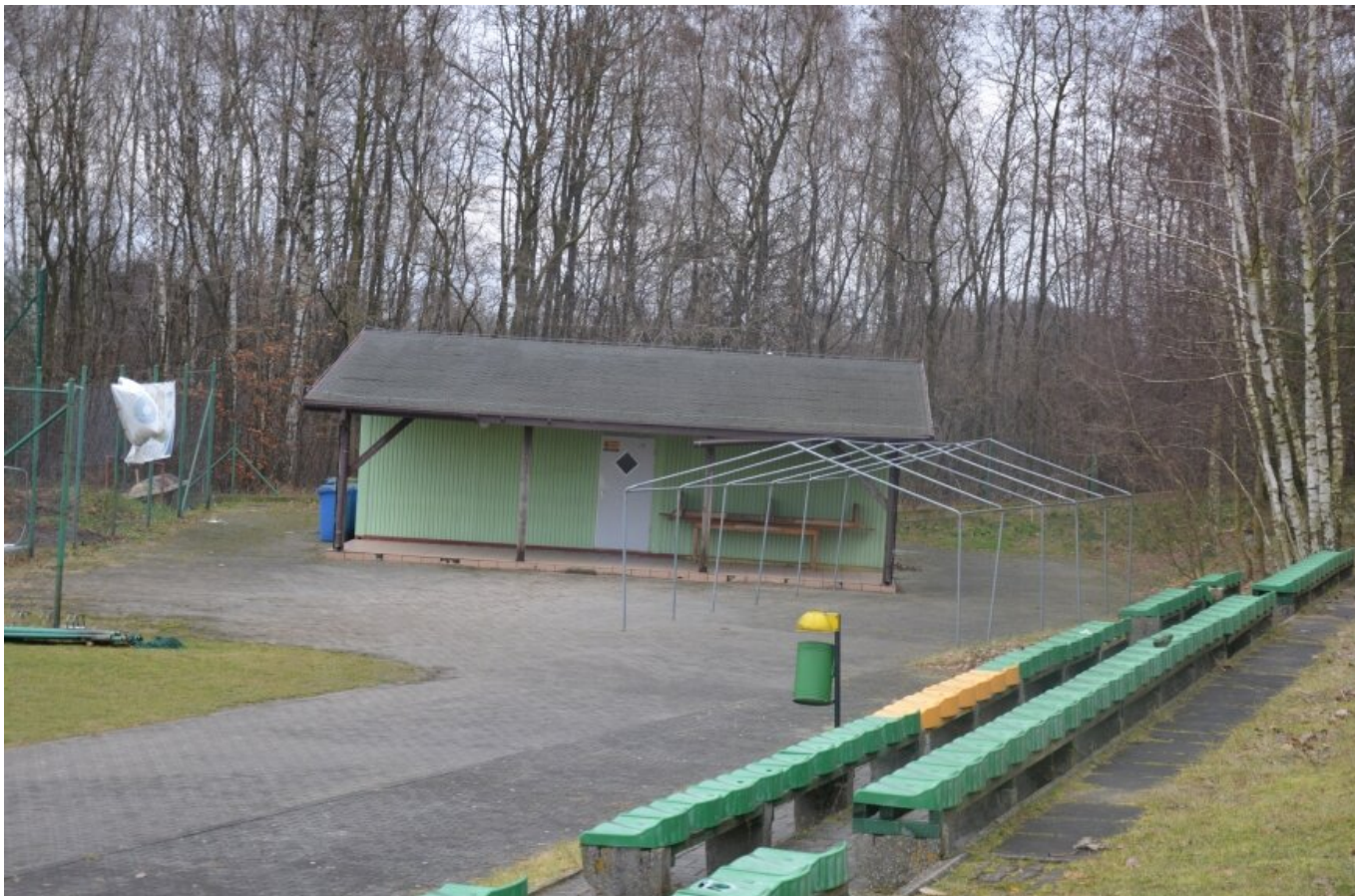
Najpierw piłkochwyty, w kolejnym etapie projekt przyszłych pomieszczeń socjalnych na boisku w Wołucz. (fot. Włodzimierz Szczepański)
