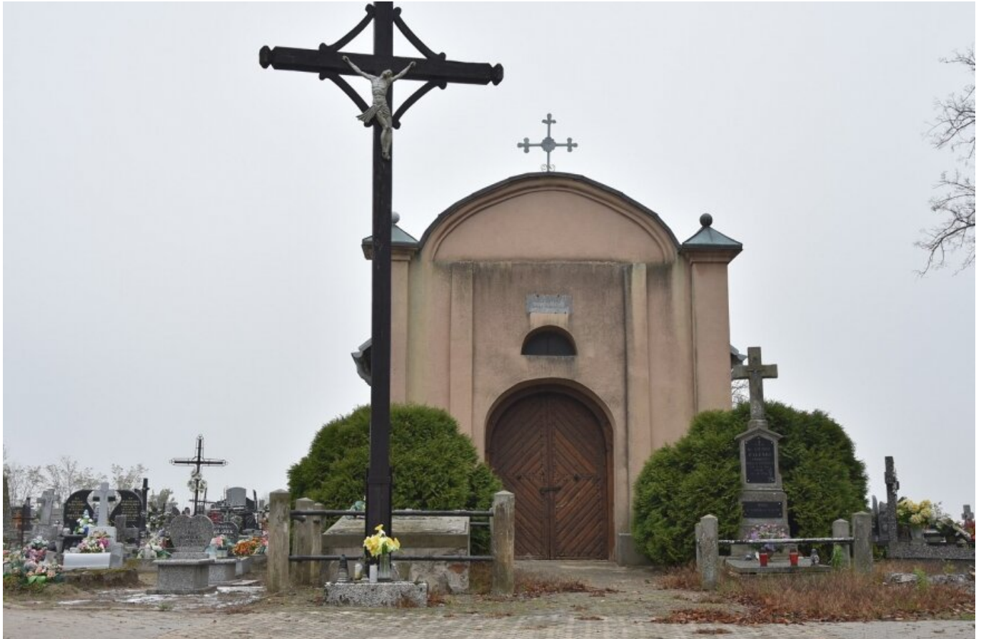
Kaplica mieszcząca się na cmentarzu w Starej Rawie ma trafić także na listę ewidencjonowanych zabytków. (fot. Bartosz Nowakowski)
