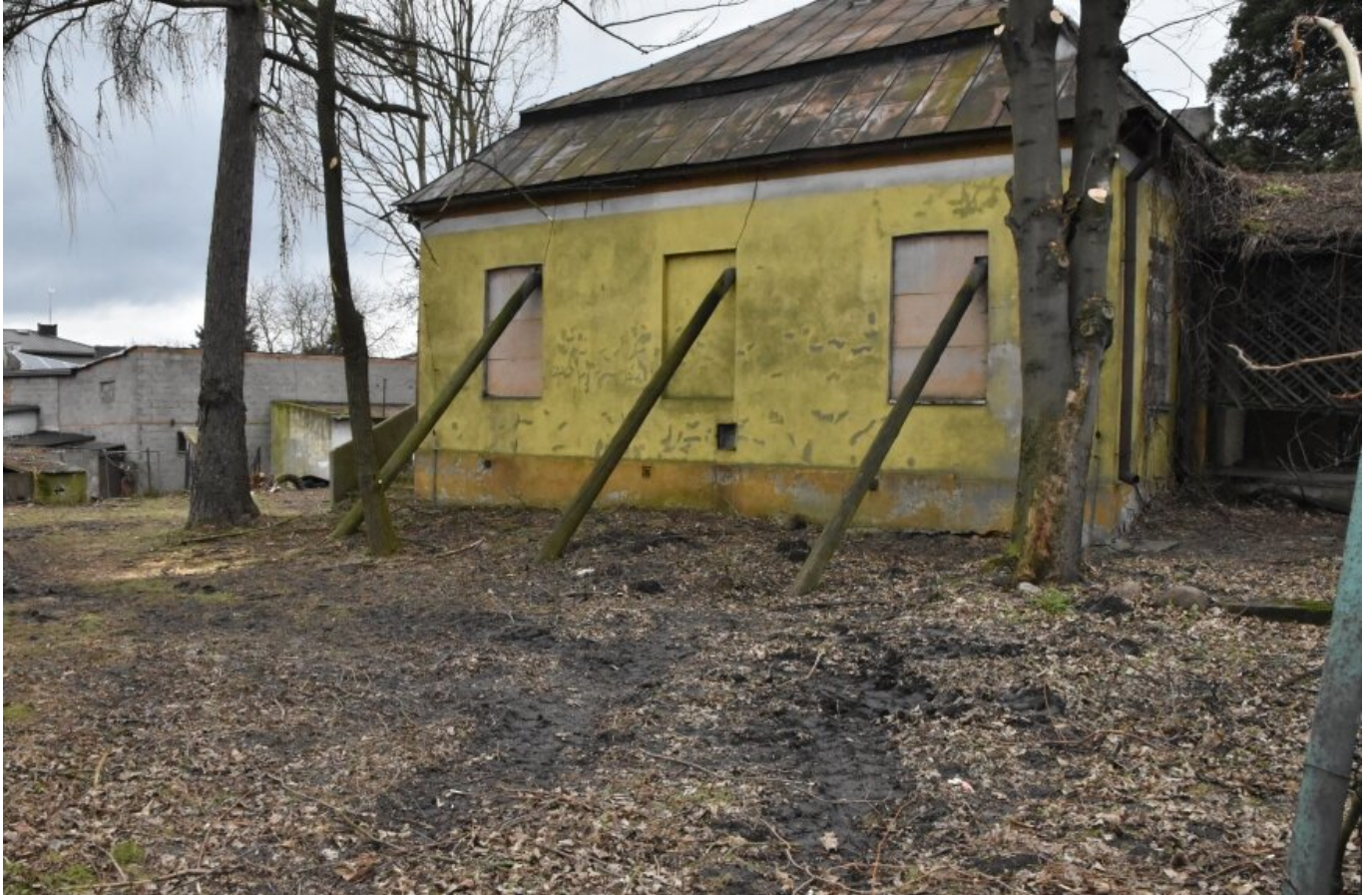
Podparte stemplami ściany nie wróżą łatwej i szybkiej przebudowy obiektu. (fot. Beata Pierzchała)
