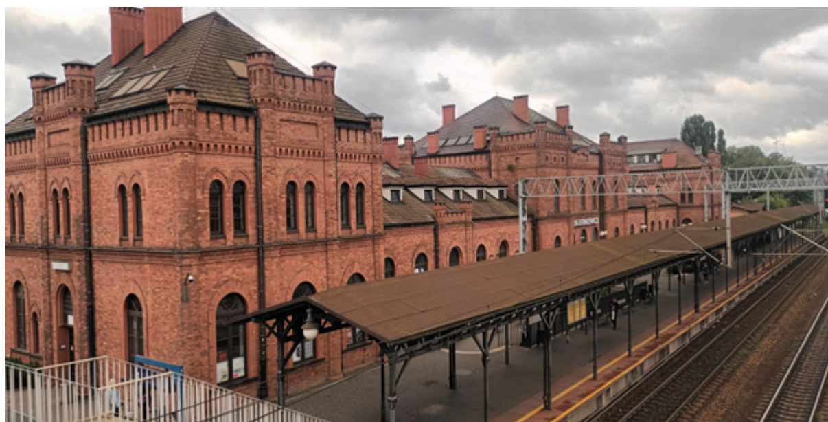
Dworzec kolejowy z wiatą peronową, źródło: radiolodz.pl
